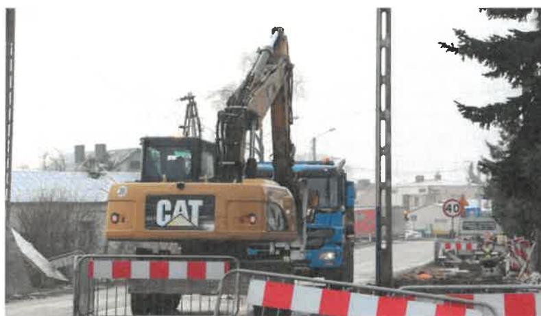
Prace prowadzone na ul. Dąbskiej w Uniejowie fot. archiwum Urzędu Miasta w Uniejowie
