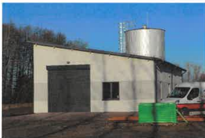
Stacja uzdatniania wody w Ostrowsku. foto arch. Urzędu Miasta w Uniejowie
