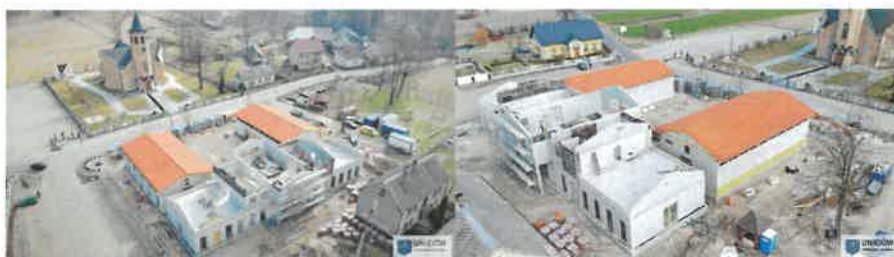
Budowa Spycimierskiego Centrum foto arch. Urzędu Miasta w Uniejowie
