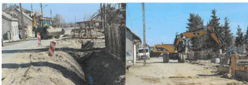
Prace wodno-kanalizacyjne w Brzezinach foto arch. Urzędu Miasta w Uniejowie
