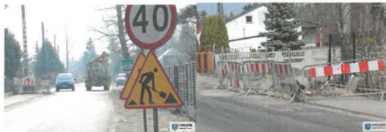
Prace wodno-kanalizacyjne na ul. Kościelnickiej w Uniejowie foto arch. Urzędu Miasta w Uniejowie
