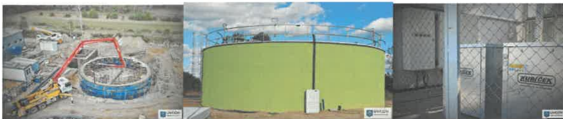
Przebudowa oczyszczalni w Uniejowie foto arch. Urzędu Miasta w Uniejowie
