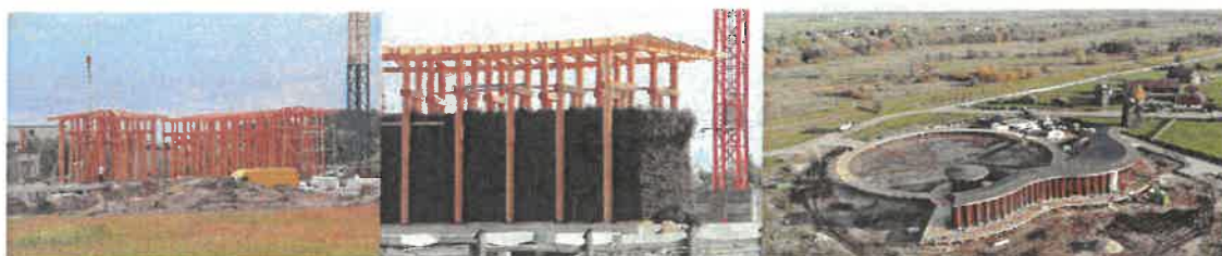
Budowa Uniejowskiej Tężni foto arch. Urzędu Miasta w Uniejowie
