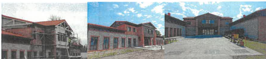
Budowa Spycimierskiego Centrum foto arch. Urzędu Miasta w Uniejowie
