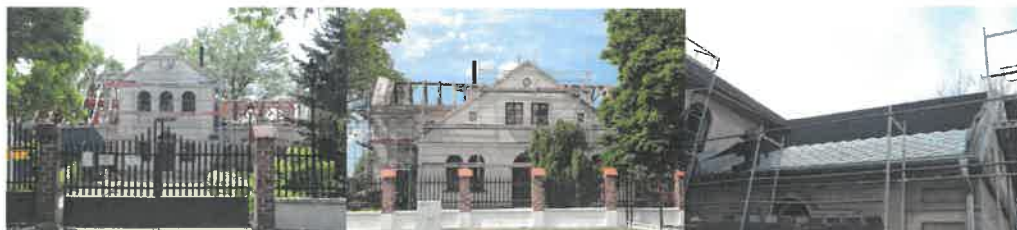
Remont dworku Foto arch. Urzędu Miasta w Uniejowie
