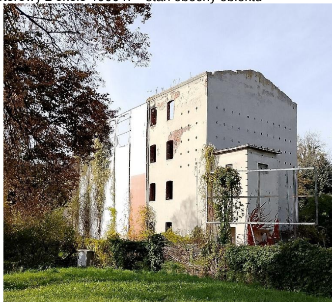
Fotografia 10 Młyn motorowy z około 1900 r. – stan obecny obiektu
