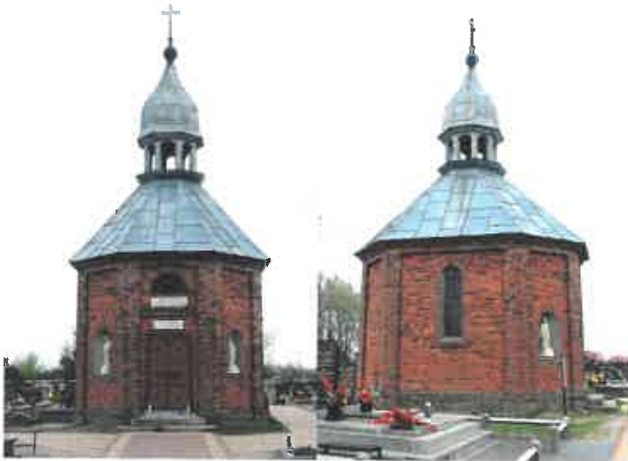
Zdjęcie nr 11, 12. Kaplica grobowa Boxów Radoszewskich na cmentarzu parafialnym, ul. Dąbska, Uniejów
